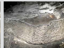
Reparación de fisuras en Molino de Bolas
