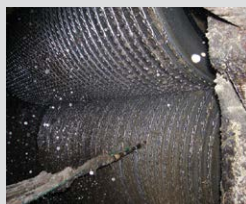
Aplicación de chapisco
